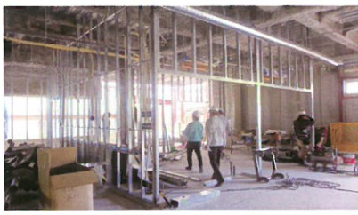
建物内1階部分
